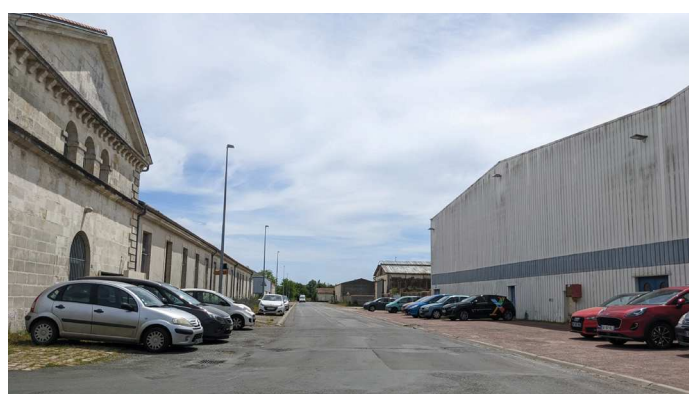
Rue de l'Arsenal au nord des magasins généraux
