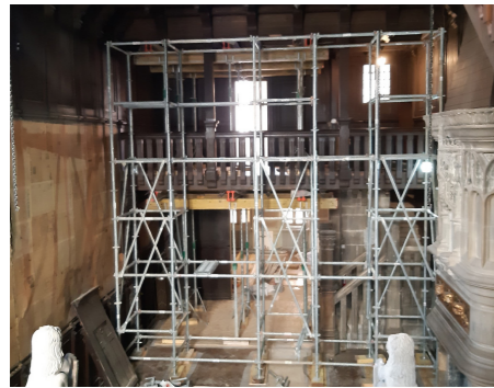
Installation de chantier pour la restauration du plafond de la salle renaissance ©Ville de Rochefort
