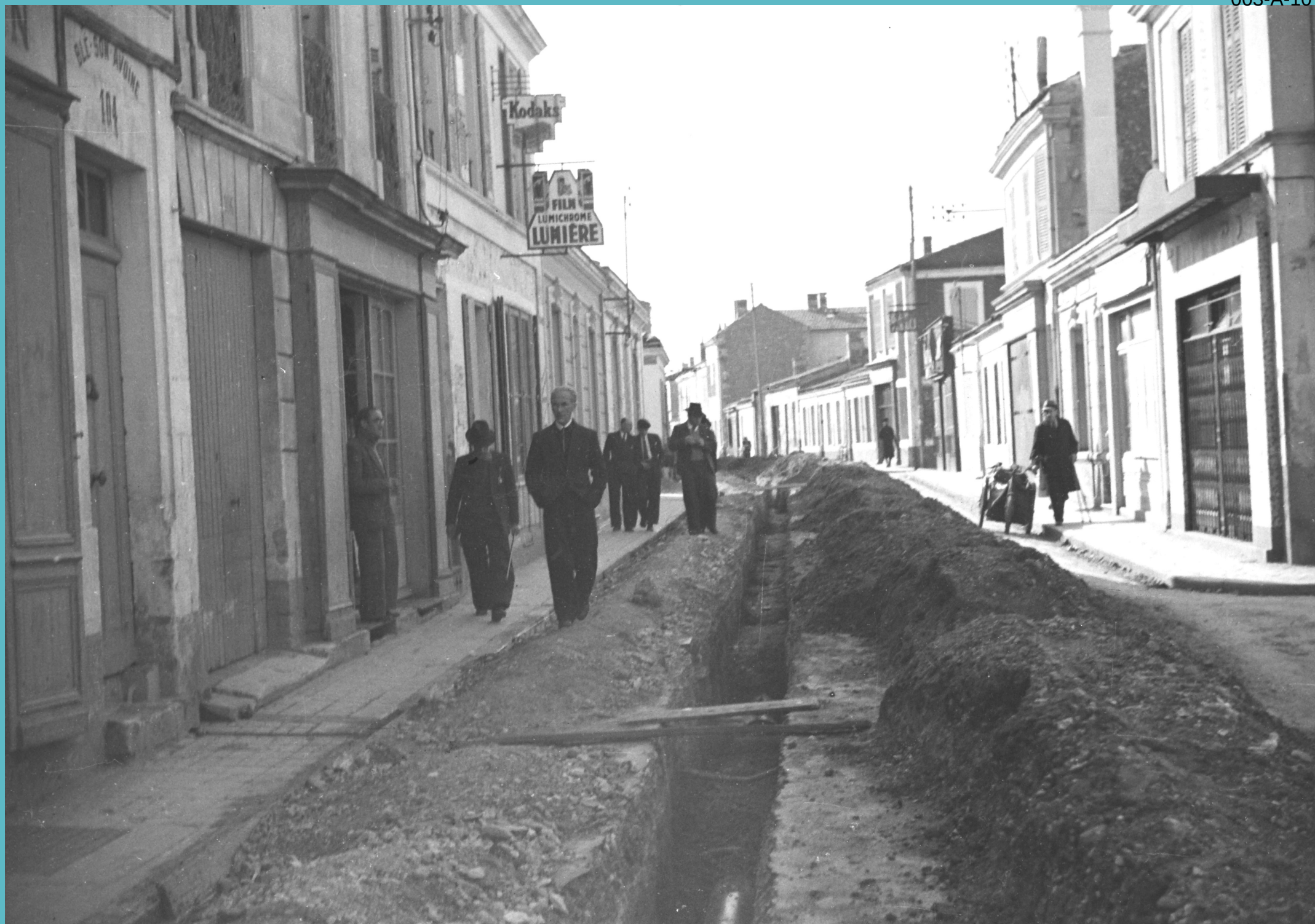
Travaux de la rue du XIV Juillet. À gauche de l'image, l'enseigne du studio de René Kériguy.
