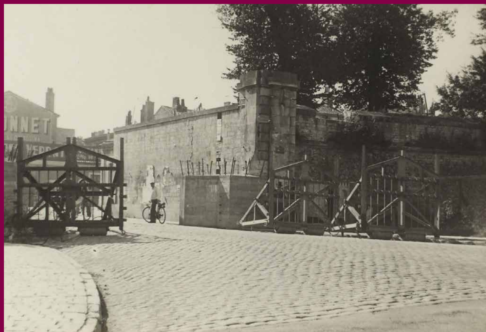
La porte Bégon protégée par des barrières anti-char.
