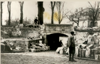
Démolition de la poterne de l'hôpital. Photographie, fonds numérique Michel Allary, AMR
