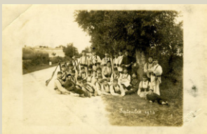
Ahlrep emporte son matériel sur le front. Il réalise des photographies de groupe de ses camarades de régiment au format carte postale que les soldats envoient à leur famille. Ses tirages sont aisément identifiables grâce au tampon sec qu'il utilise. Photo-carte Ahlrep, 2005I8/3FI96, AMR
