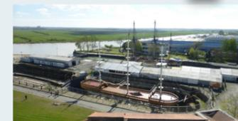
Destinées à faciliter la réparation des navires, les formes de radoub maçonnées ont été mises au point à Rochefort, en 1670. Aujourd'hui utilisées à d'autres fins, la Forme Double et la Forme Napoléon III témoignent par leurs tailles de l'évolution des flottes de guerre aux XVIII<sup>e</sup> et XIX<sup>e</sup> siècles.
