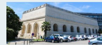
Inauguré en 1876, l'ancien château d'eau est le premier ouvrage qui puisse répondre aux besoins en eau potable de la ville. Sa structure massive porte de puissants réservoirs en béton considérés comme des modèles pour l'époque.
